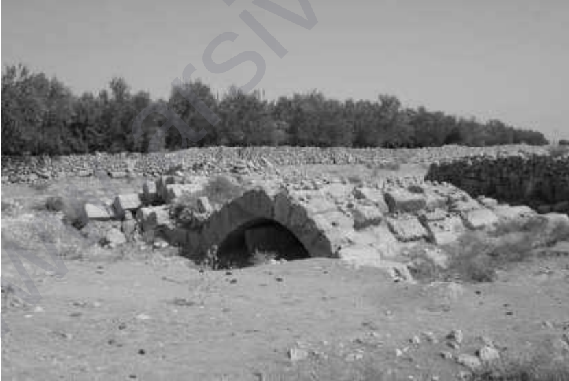
Fotoğraf 2. Dara II. Köprüsü’nün Genel Görünüşü.
