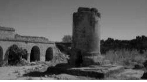
Resim 2. Manastırın yıkık haldeki güney duvarı
