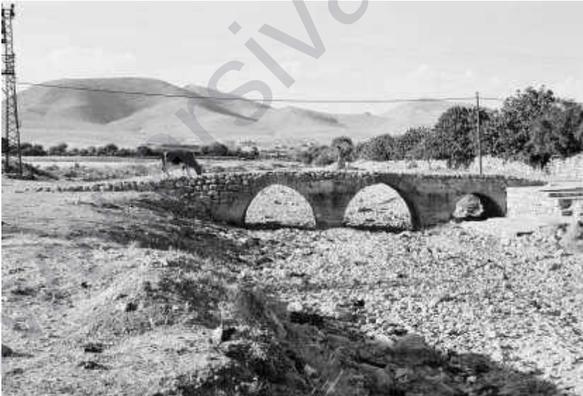
Fotoğraf 4. Harzem Köprüsü'nün Genel Görünüşü.
