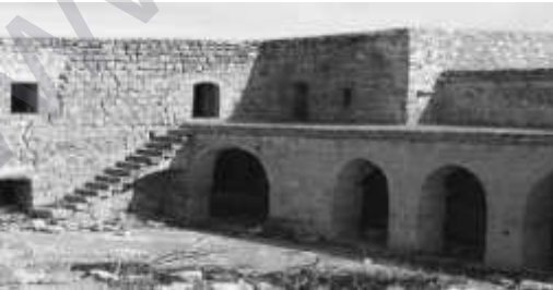
Resim 4. Kesme taştan yapılmış merdiven
