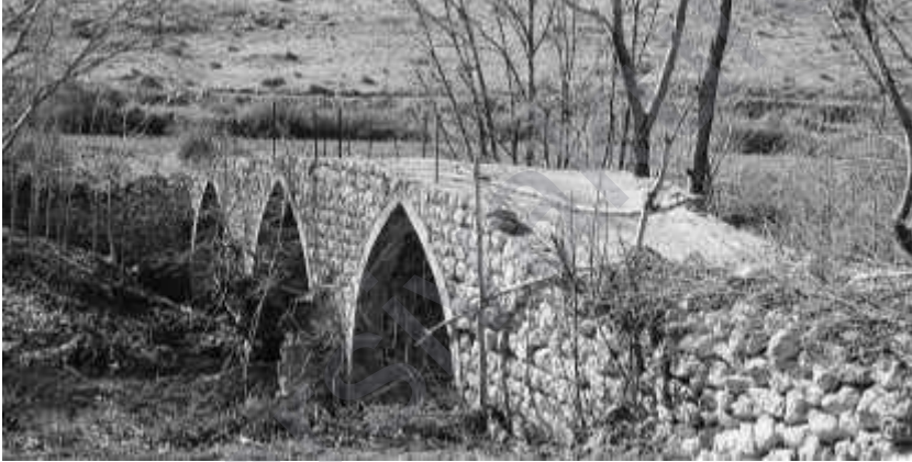
Fotoğraf 8. Hisarkaya Köyü Köprüsü'nün Genel Görünüşü.
